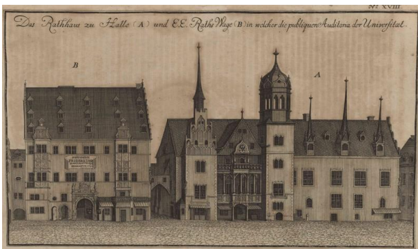
Abb. 1: Ansicht von Waage und Rathaus
