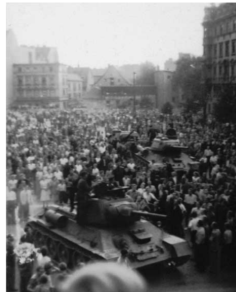
Abb. 2: 17. Juni 1953: Sowjetische Panzer sorgten auf dem Hallmarkt für das Ende des Volksaufstandes in Halle
