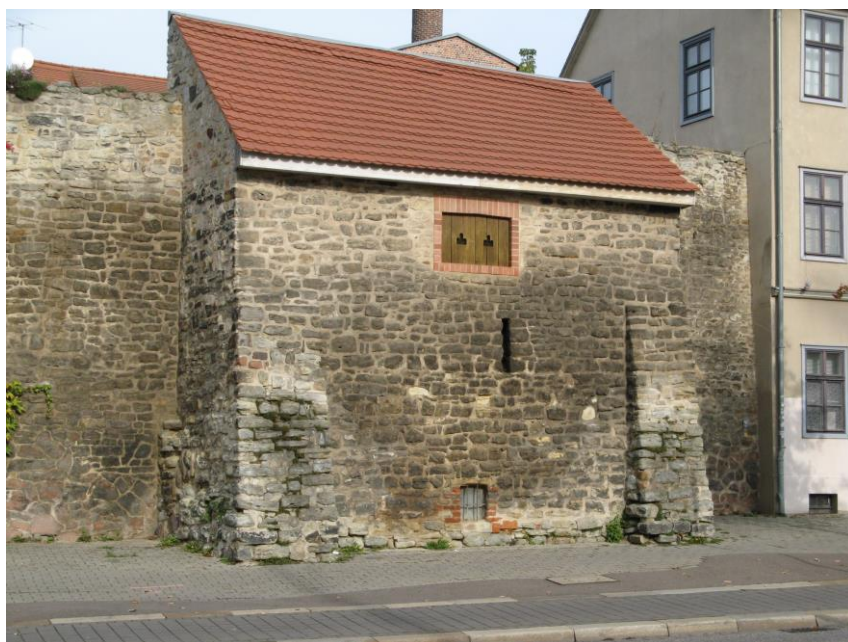
Abb. 2: Rest eines Stadtmauerturms am Waisenhausring (Große Brauhausstraße 5/6) Foto: Peter Breitkopf.
