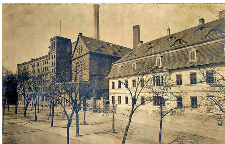
Das Fabrikgebäude der Hallischen Zuckersiederei-Compagnie.
